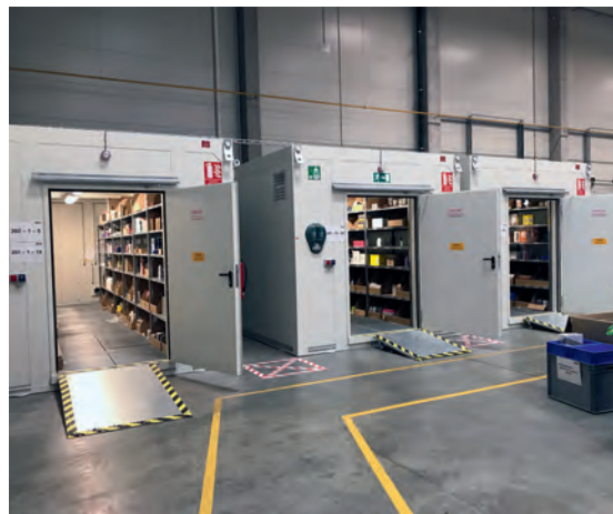
Obr.: Protipožární kontejnery DENIOS ve skladovací hale
